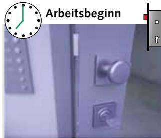
Die Tür kann nur mit einem Schlüssel von außen geöffnet werden. Riegel zurückschließen und über Wechsel-funktion öffnen.
