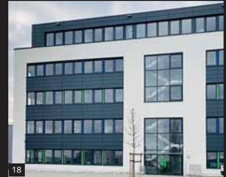
RC-Office Büro- und Technikcenter Cologne/Germany
