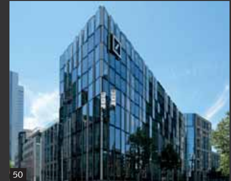
Deutsche Bank Campus Süd Frankfurt Main/Germany
